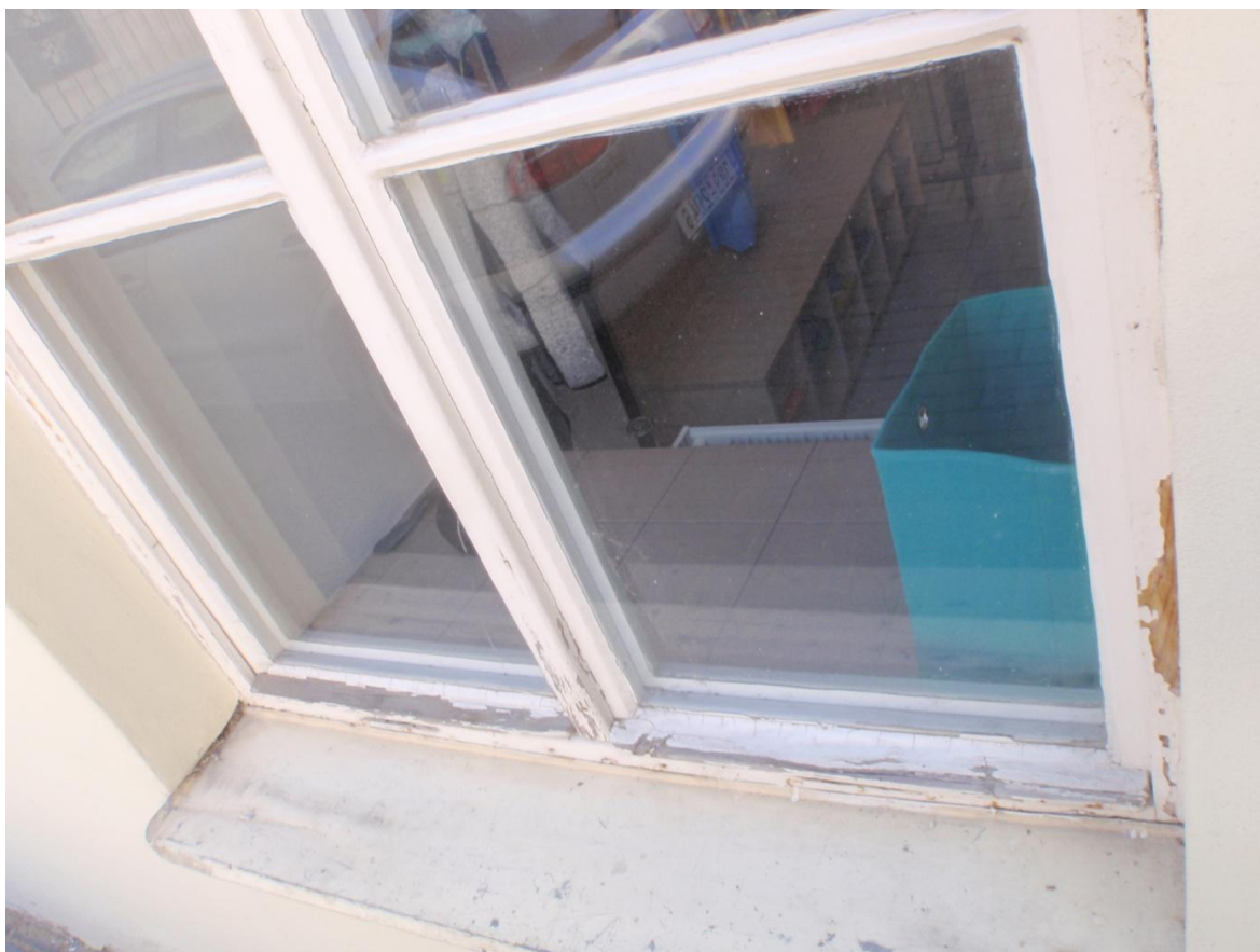
Pohled vnější - na parapetní část stávajícího okna určeného k výměně za nové.
