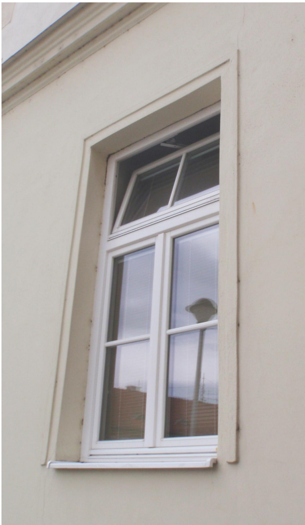
Pohled vnější - na již vyměněné okno v uliční fasádě – vzor pro výrobu zbývajících oken určených k výměně.
